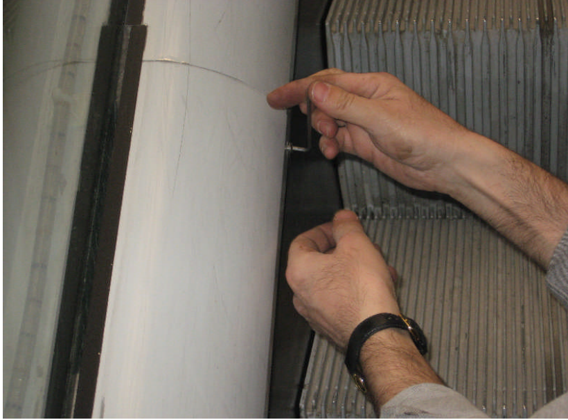
Resim 2.8: Süpürgeliğin sökülmesi
