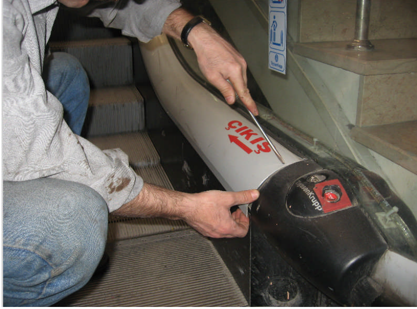
Resim 2.9: Süpürgeliğin çıkarılması
