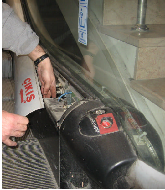
Resim 2.10: Süpürgeliğin çıkarılması
